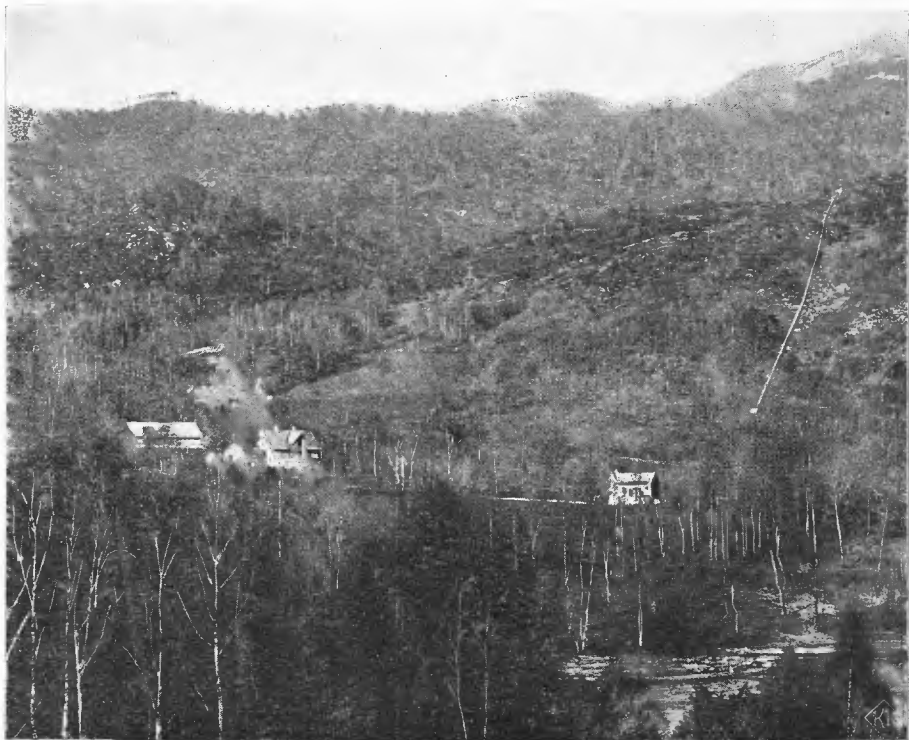
Søndre Valen med kraftstation og rørledning.
