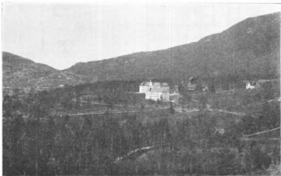
Asylbygningerne. Til høire administrationsbygningen. I forgrunden sees taket paa kraftstationen.
