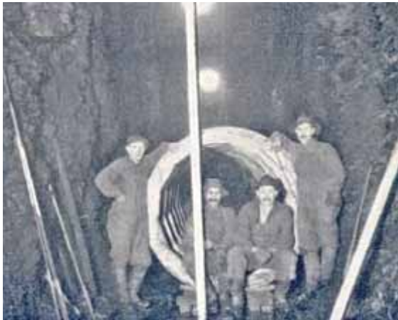
Bygging av kloakktunnel under Stortorvet: Kloakksystemer er underjordiske rørledninger som transporterer spillvann, regnvann, avføring m.m. fra bebodde steder. Et velordnet kloakknnett av den største betydning for folkehelsen, blant annet fordi det hindrer nærkontakt med fekalier som kan føre til sykdom. Den moderne kloakkteknikk oppstod i Storbritannia på begynnelsen av 1800-tallet samtidig med industriens oppsving. De første større kloakkanlegg skriver seg fra tiden omkring 1840. Kilde: Store Norske Leksikon Faksimilé fra O. Pedersen (1924): Vore dages Kristiania, Kristiania: Forlagstrykkeriet
